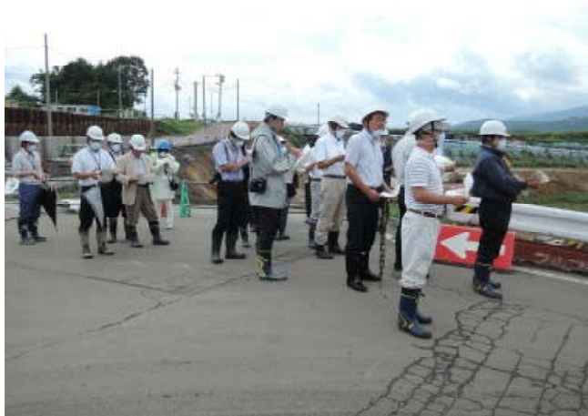
青森県側現場視察状況
