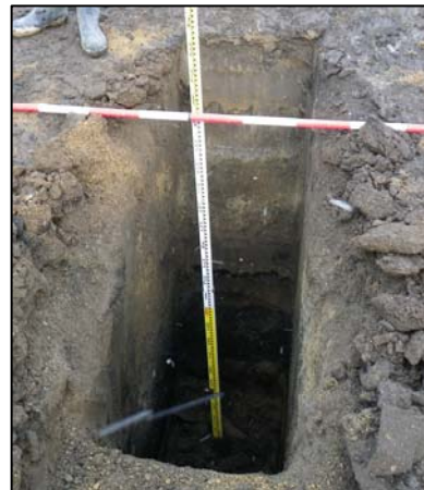
試掘完了(H=2m)
