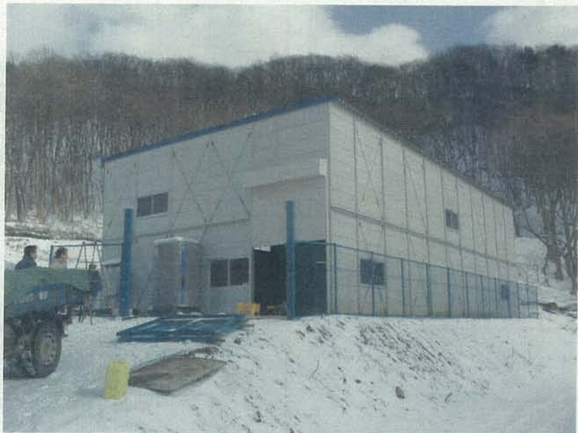
仮設浄化プラント全景
