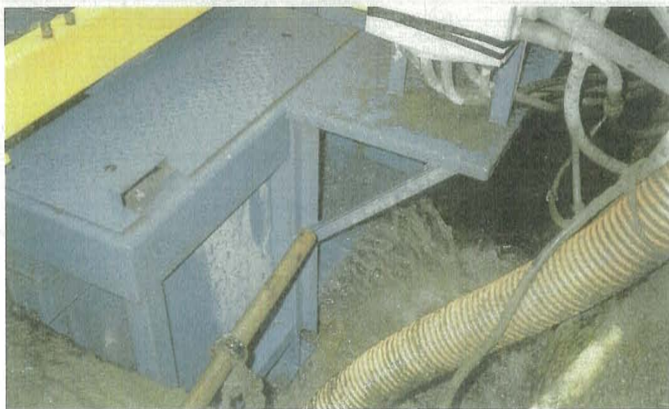
【写真 6-10】シューターより排出される洗浄後の水
