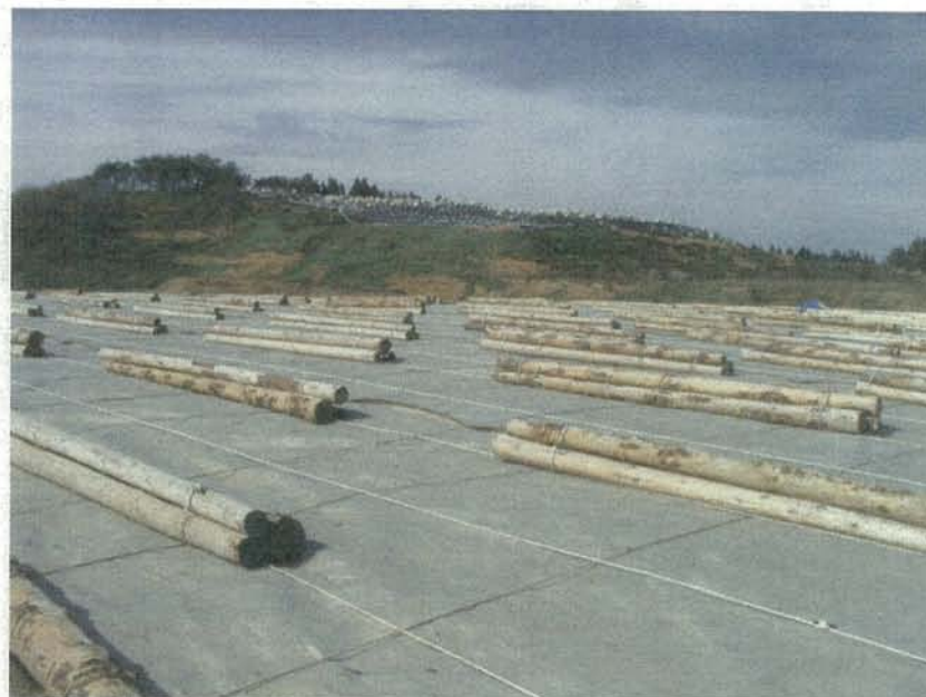
遮水シート押さえ工（県産間伐材）
