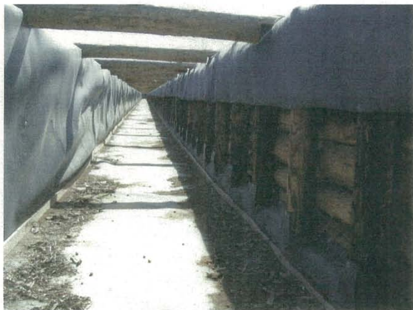
木製水路工内部
