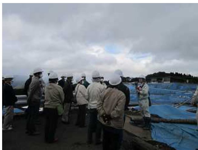
現場全景を見学
