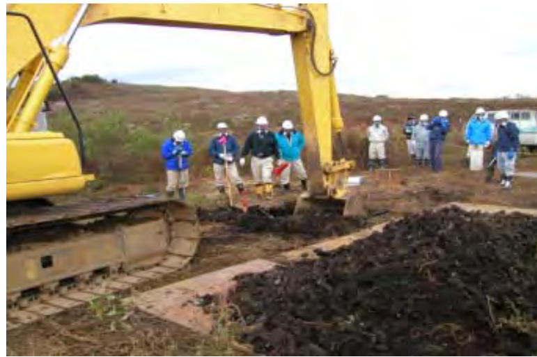
写真1 重機掘削状況
