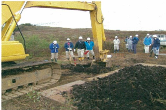
写真1 重機掘削状況
