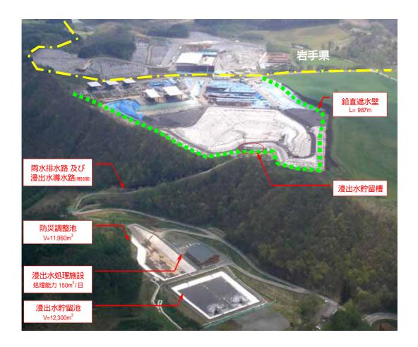
周辺への汚染拡散防止対策として遮水壁(長さ約980m、平均深さ約20m、厚さ約50cm)を設置し、汚染水が周辺環境へ影響することを防止するとともに、現場内の汚染水を処理するための浸出水処理施設が稼働しています。廃棄物撤去完了後のこれらの取扱いも今後の検討課題となっています。
