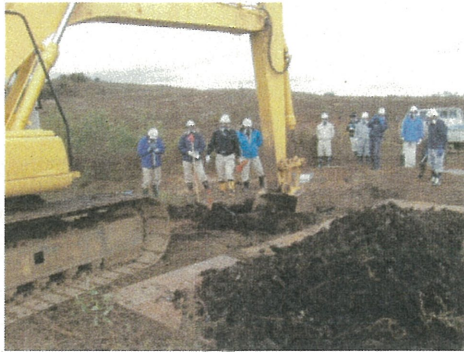
写真1 重機掘削状況
