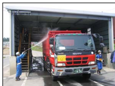
トラックをあらう所 (洗車設備)
