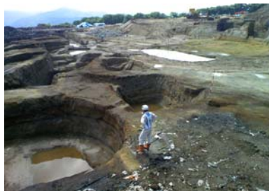
元々の地面の一部に穴を掘り捨てていました。
