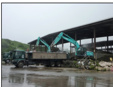
廃棄物の積みこみ (廃棄物選別ヤード)
