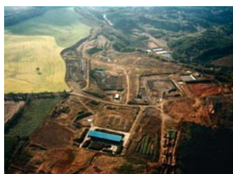
ごみを片づける前の現場 (平成12年10月)
