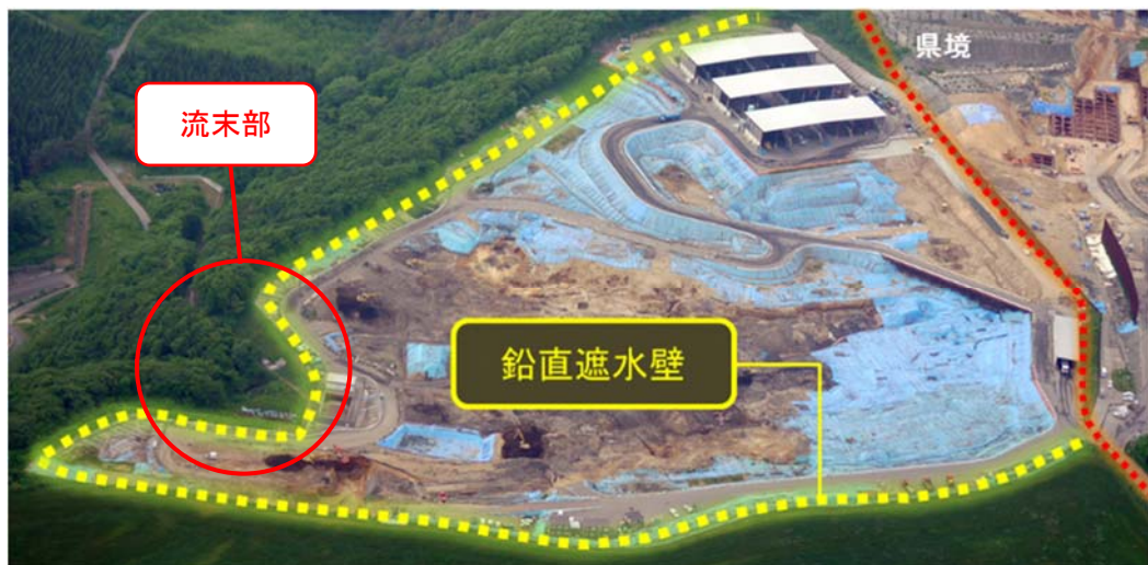
<本県側の不法投棄現場全景>
