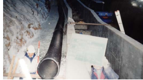
浸出水導水管(※埋戻し前)
