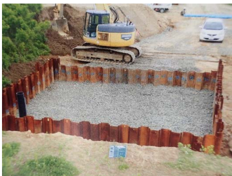
浸透柵(※仮設撤去前)
