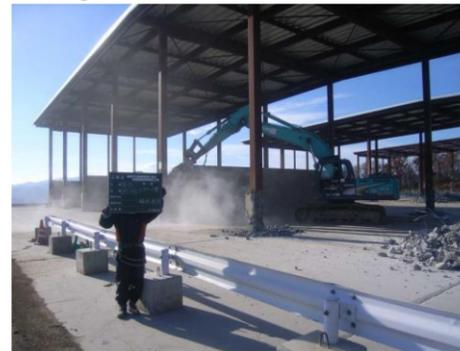
写真② 上屋撤去完了(柱の一部が残存)
