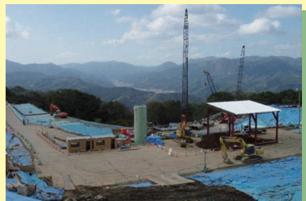
平成17年10月の遮水壁工事状況
