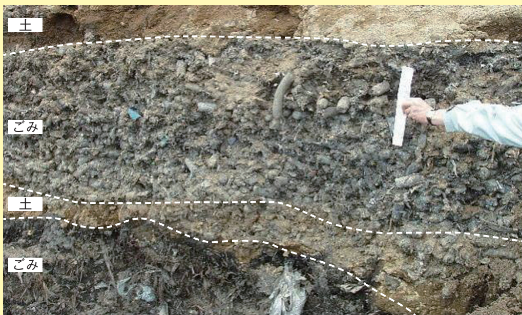
ごみの上に覆土して隠す投棄方法が繰り返されていました。
