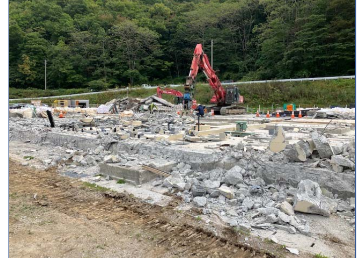
浸出水処理施設撤去工事 施工状況
