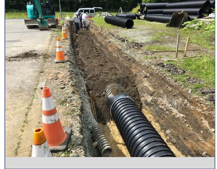
浸出水処理水放流管撤去工事 施工状況
