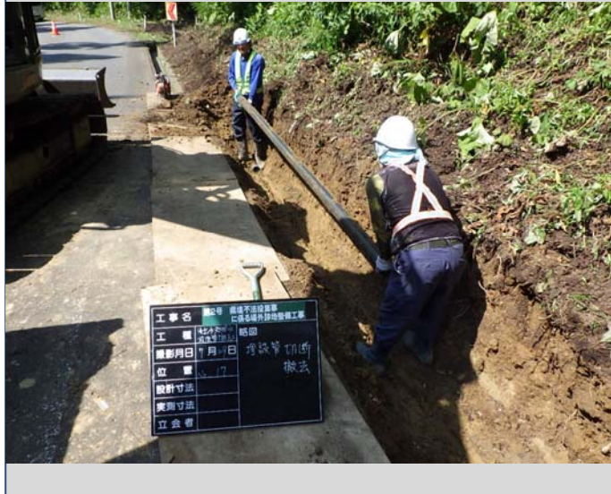
浸出水処理水放流管撤去工事 施工状況
