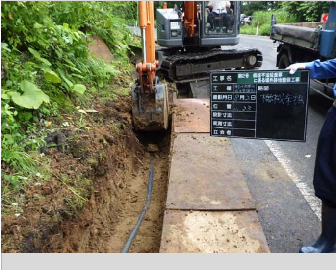
浸出水処理水放流管撤去工事 施工状況
