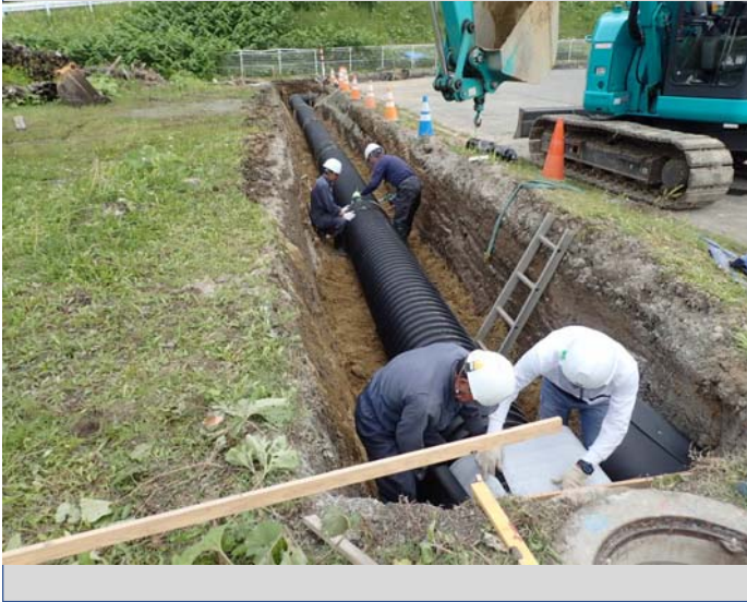
浸出水処理水放流管撤去工事 施工状況
