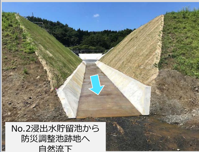
浸出水貯留池改修工事 堰堤開削部
