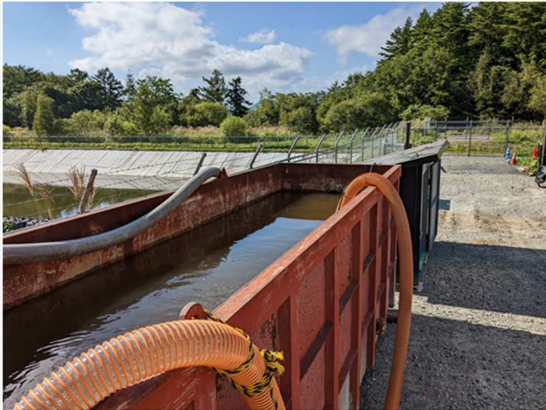
実際の浸出水を入れた貯留槽で試運転を実施 (1,4-ジオキサン 0.10mg/L)
