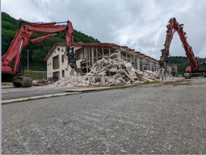
浸出水処理施設撤去工事 施工状況
