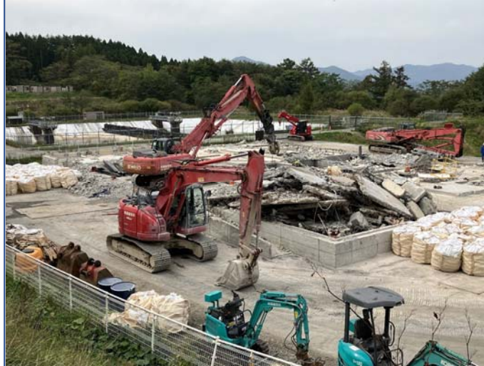
浸出水処理施設撤去工事 施工状況
