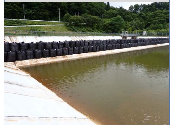
浸出水貯留池改修工事 堰堤嵩上げ（大型土のう）
