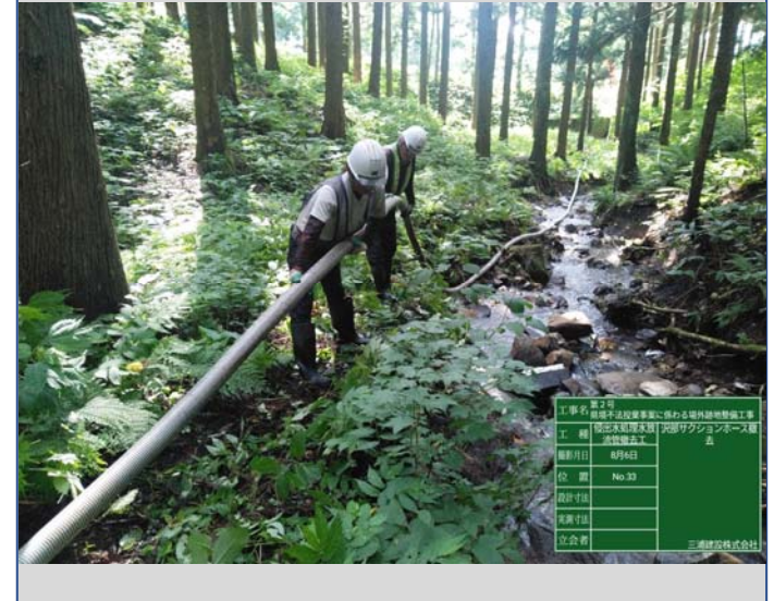
浸出水処理水放流管撤去工事 施工状況
