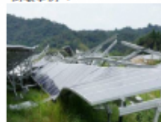
パネル飛散の例-2
