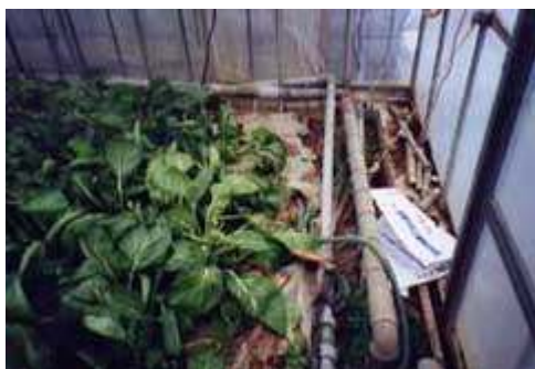
写真の配管の中に温泉を流している
