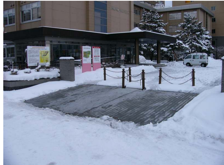
弘前大学敷地内における融雪状況
