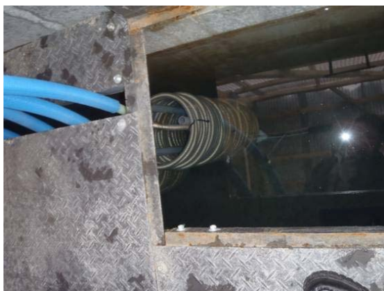
図 6.2-2 駒草荘写真（左：熱交換器、右：温泉排湯熱利用設備）
