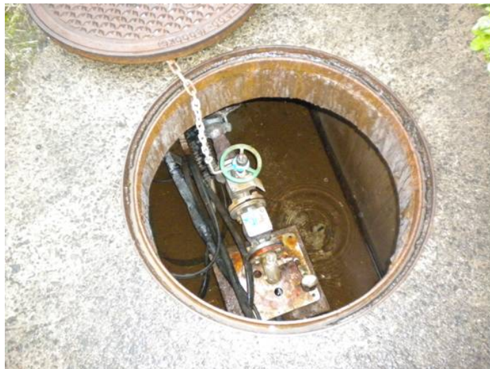
図 2.3-7 菴頭源泉 坑口ピット
