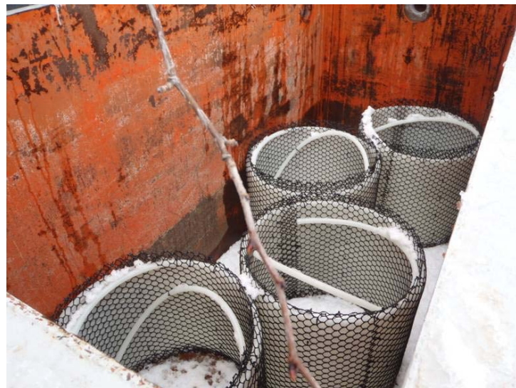
図 4.1-8 施工状況（投げ込み式熱交換パイプ）
