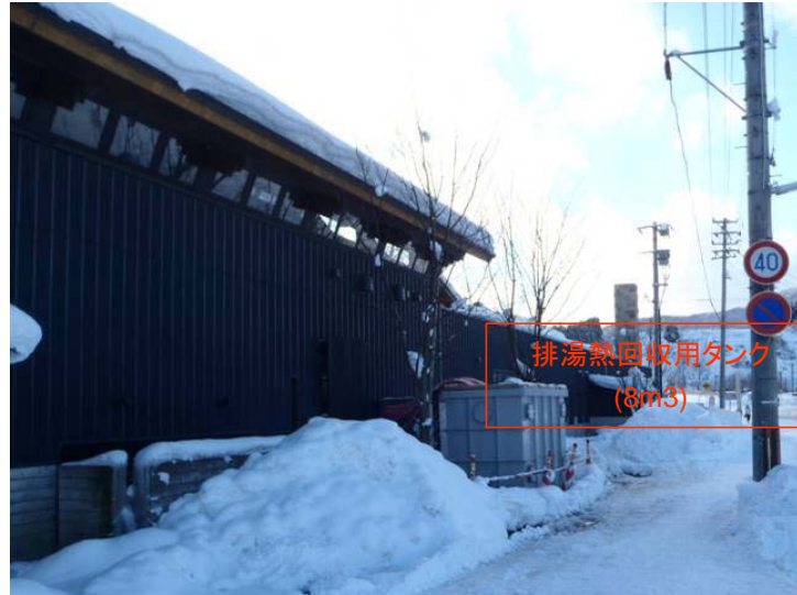
図 4.1-7 施工状況（熱交換用タンク）
