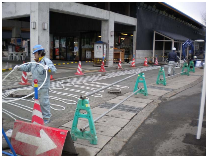
図 4.1-5 施工状況（放熱パイプ敷設状況）
