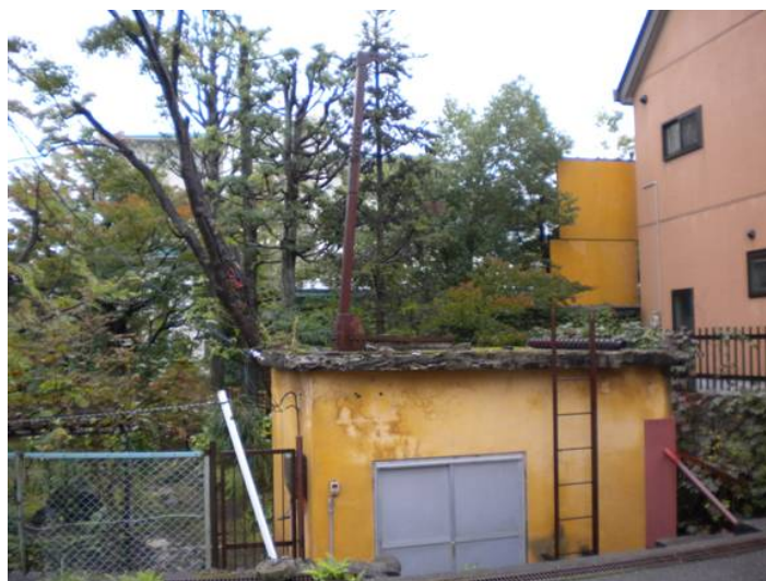
図 2.3-4 石原源泉機械室外観
