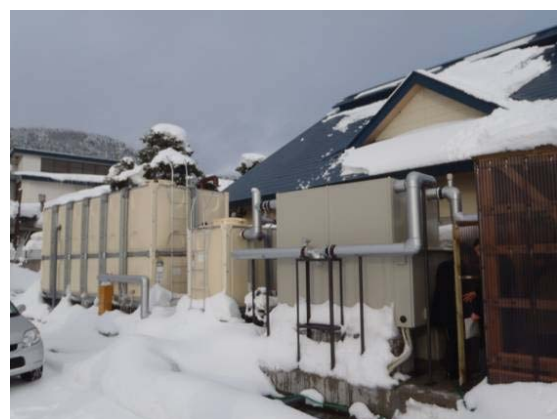
図 6.2-2 駒草荘写真（左：熱交換器、右：温泉排湯熱利用設備）
