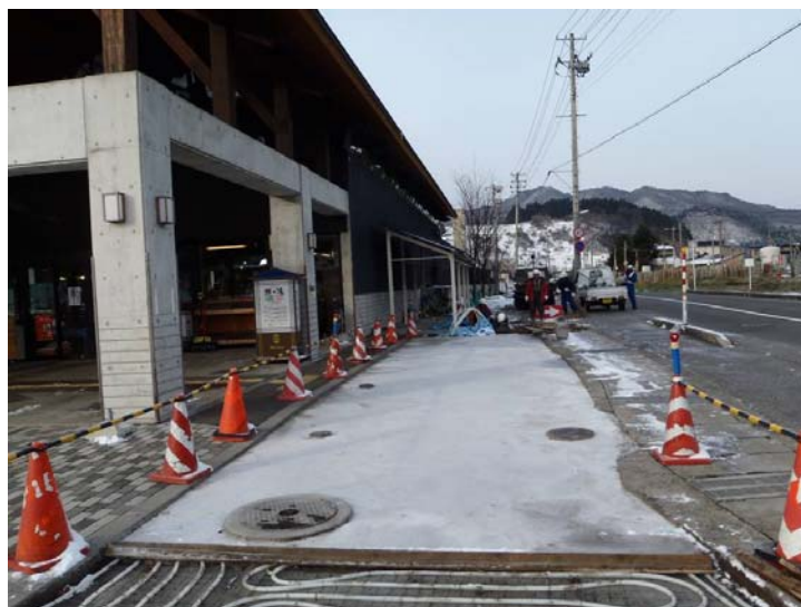
図 4.1-6 施工状況（押さえコンクリート打設後）
