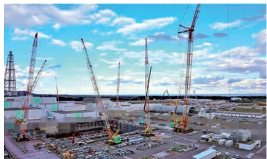
MOX工場建設中写真
