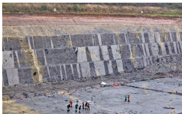
3号廃棄物埋設施設(岩盤検査)
