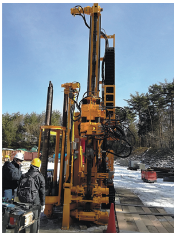
NEDO 再生可能エネルギー熱利用技術開発北大コンソーシアム企業が開発したボーリングロッドのマガジンと自動脱着装置付きのポアホール掘削機
