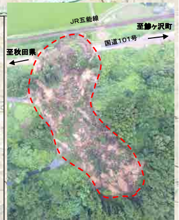
国道101号迂回路（深浦町黒崎地内）
