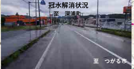
国道101号と弘前岳鱒ヶ沢線との交差点付近
