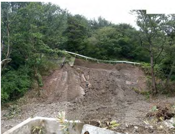
【林道被害（深浦町）】
