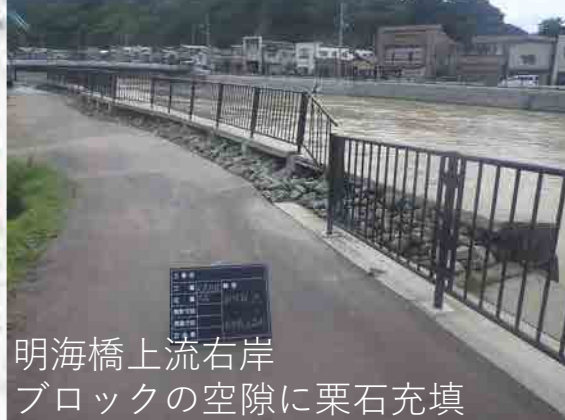
右岸河口付近 護岸崩壊箇所 大型土のう投入完了 (R4.8.11_7時30分から開始)
