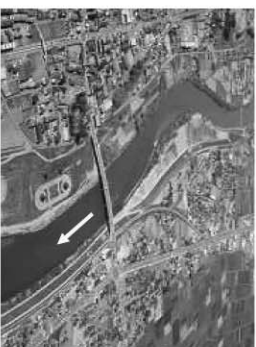
＜馬淵川下流部(大橋付近)＞
