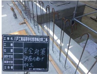
差し筋曲げ加工による転倒時、足場転落時の刺創を防止
