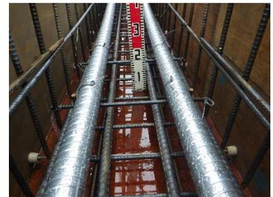
PC工事のシース管を捨て筋に固定し、打設時の移動を防止
