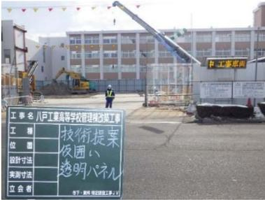
透明仮囲いパネルによる見通し向上による衝突事故を防止
