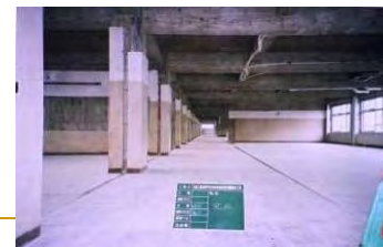
(3) 躯体劣化部補強完了
