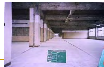
(3) 躯体劣化部補強完了
