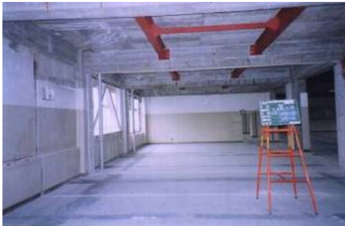
(3) 躯体劣化部補強完了
