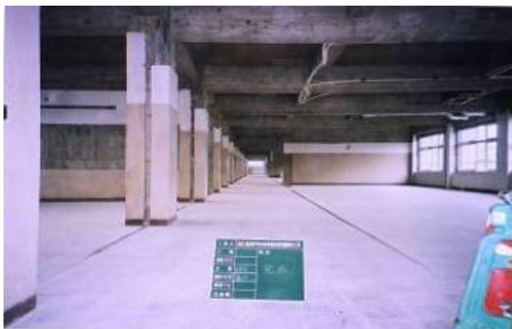
(3) 躯体劣化部補強完了
