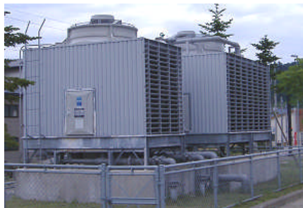
水を蒸発させ冷却
