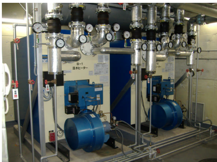
ボイラーは故障などに備え複数台に分けて設置されることが多い
