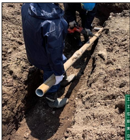
消火配管切回し状況
