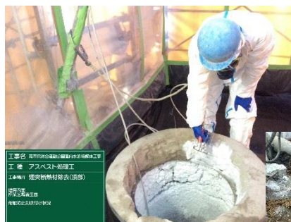
煙突内アスベスト除去状況
