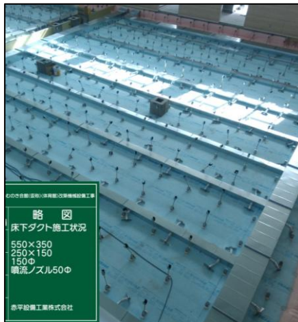
床輻射式冷暖房システム ダクト設置状況
