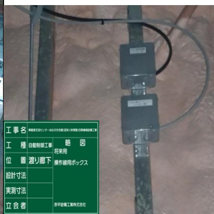
制御線工事 (将来工事対応)
