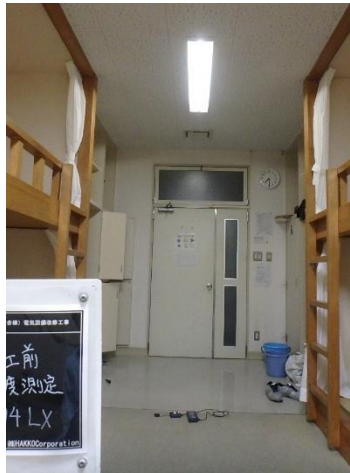
既存照明 照度測定状況
