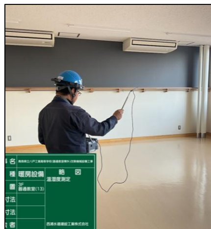
エアコン試運転状況
