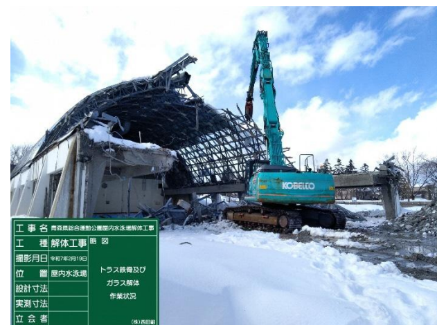
屋内水泳場上屋解体状況
