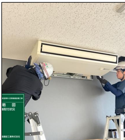
室内機取付状況
