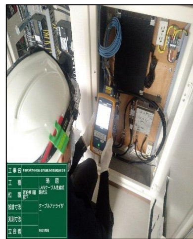
LANケーブル試験状況
