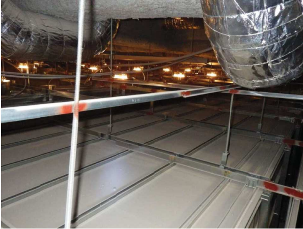
天井裏の状況
