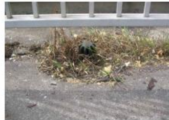
ルーフトレンの詰り(雑草が繁茂状態)ここまでくると最悪です。
