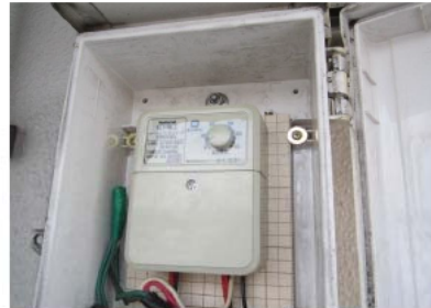
図7-1-(1) 東青地域県有施設のドレンヒーターサーモ (サーモスタッド：設定4℃)
