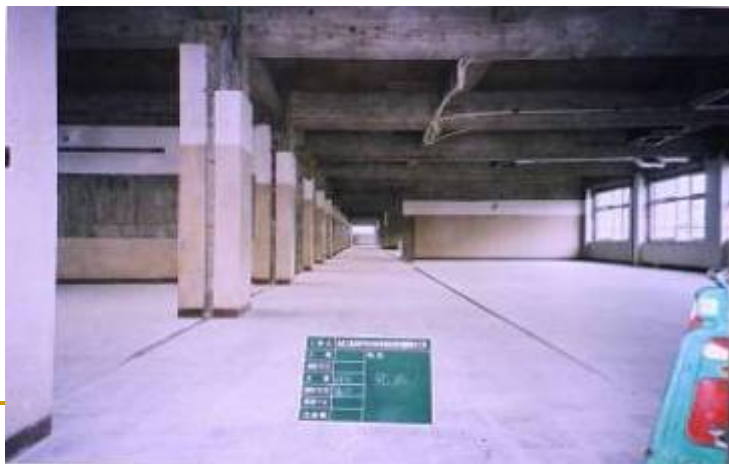
(3) 躯体劣化部補強完了
