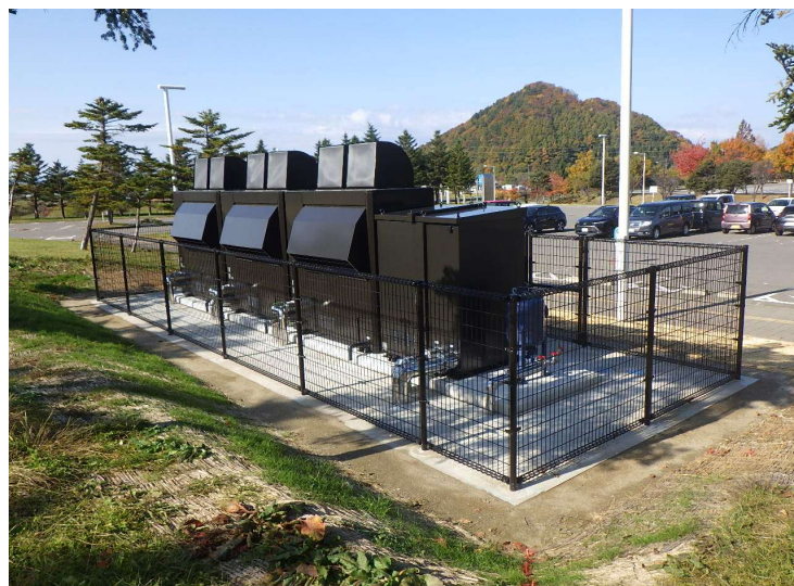
■新青森運動公園融雪施設改修工事_青森市 完成検査：令和7年12月24日
