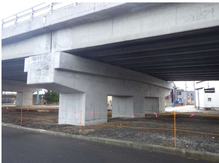
■青森港改修（施改補助）埠頭大橋橋梁補修工事_青森市 完成検査：令和7年12月27日
