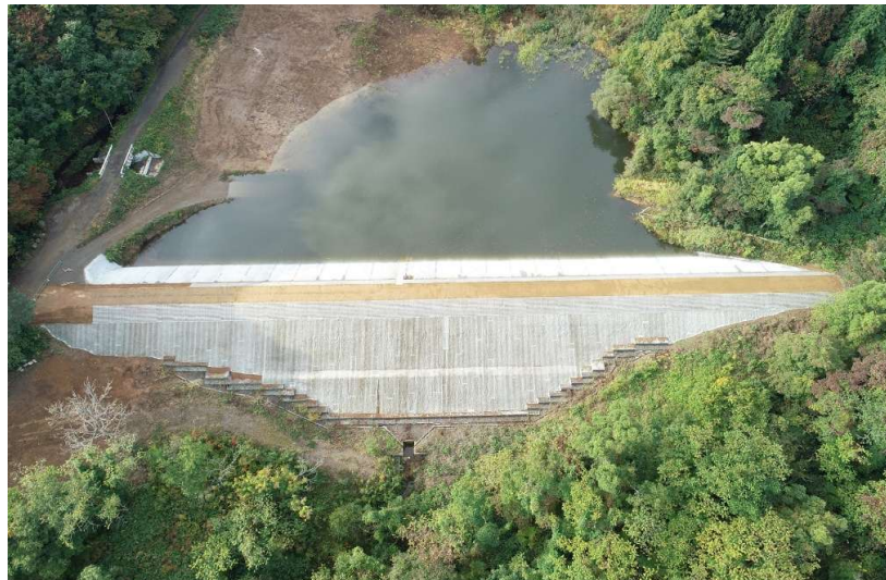
■ 小杉沢1号ため池第7号工事_弘前市 完成検査：令和7年11月12日
