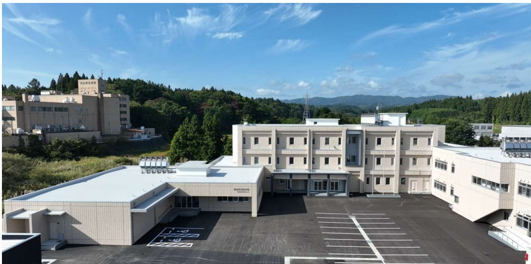
■青森県消防学校(校舎・屋内訓練場)改築工事_青森市 完成検査：令和7年10月3日
