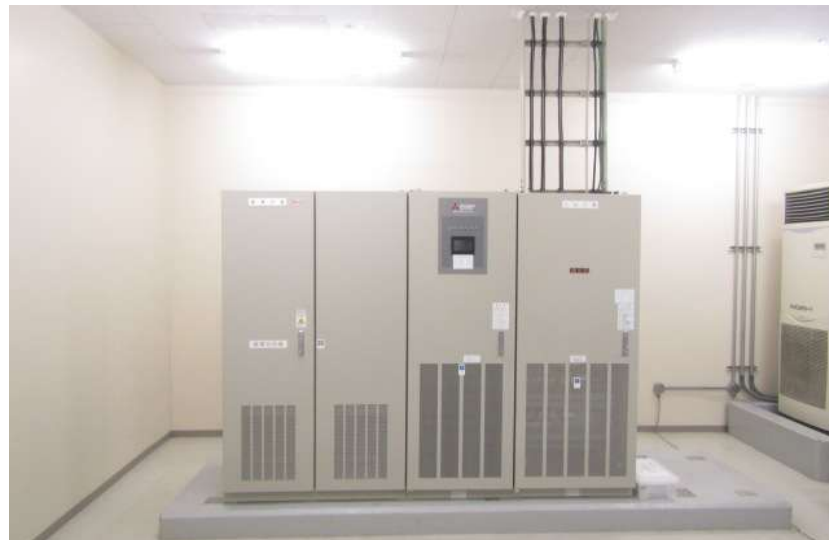
■青森県立中央病院電気設備工事（令和6・7年度）_青森市 完成検査：令和7年12月19日
