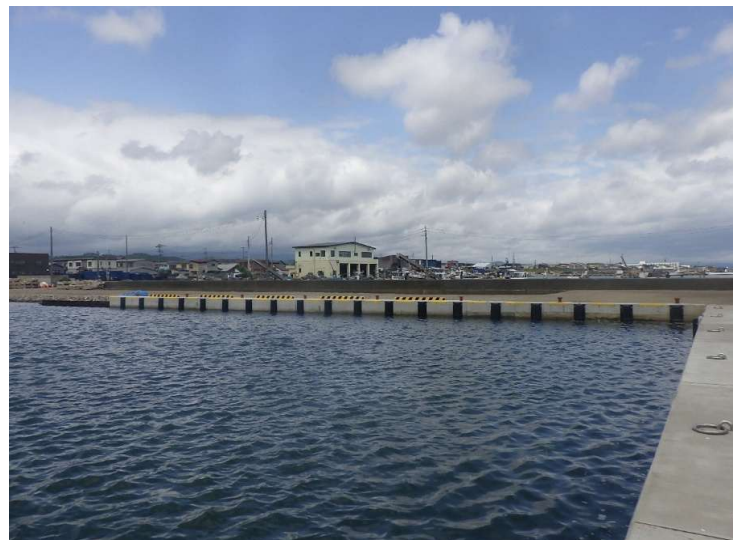
■奥内漁港港整備工事_青森市 完成検査：令和7年6月18日
