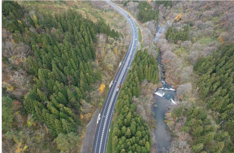
■後平馬屋尻線交付金（道路改築）工事_青森市 完成検査：令和7年12月25日
