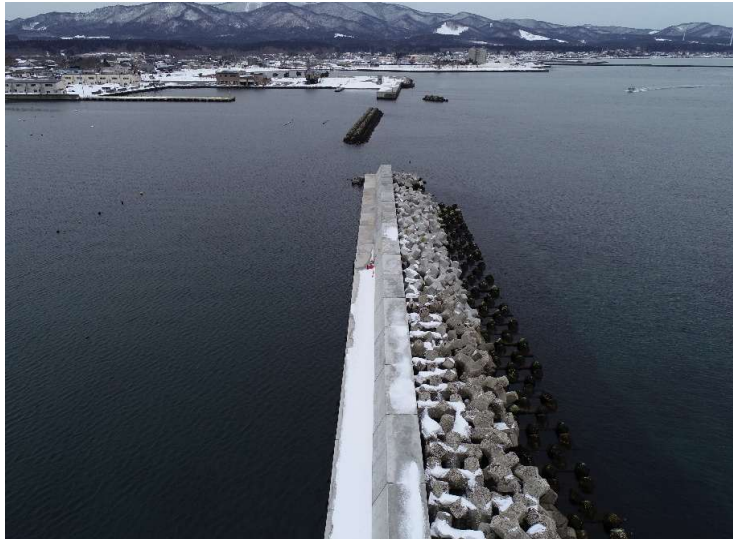
■野辺地地区水産生産基盤整備工事_野辺地町 完成検査：令和8年1月28日
