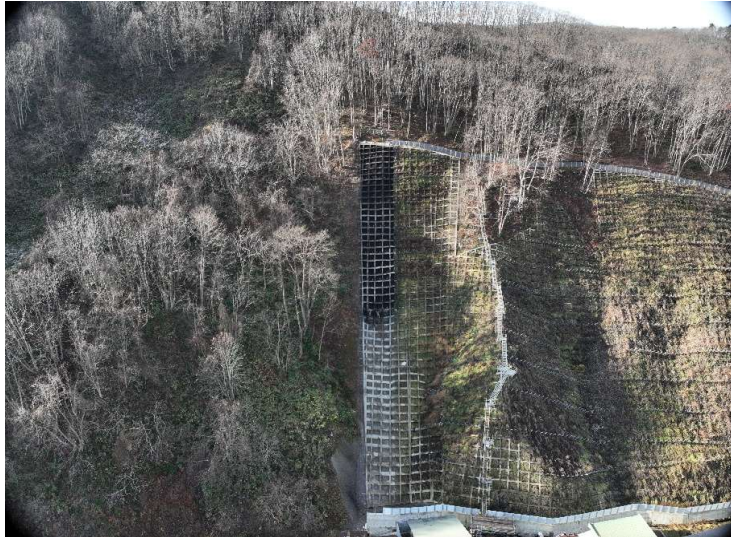
■川部急傾斜地崩壊対策工事_青森市 完成検査：令和7年12月26日
