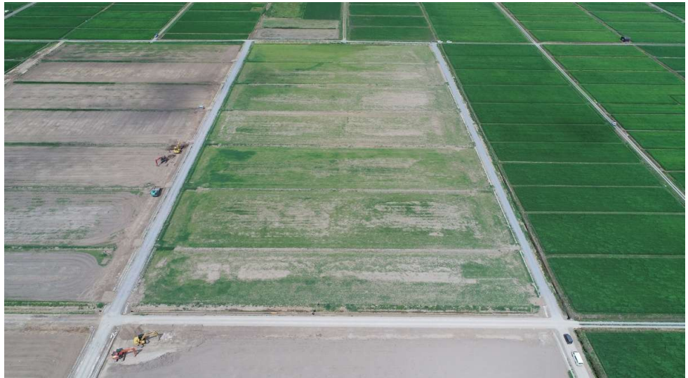
■蓬田第一ほ第1号工事_蓬田村 完成検査：令和7年7月31日
