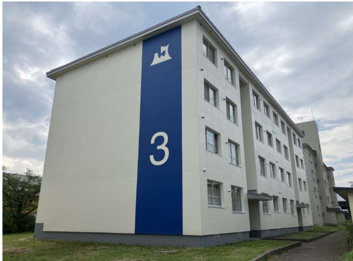
■県営住宅（茂森団地）屋根・外壁等改修工事_弘前市 完成検査：令和7年9月12日
