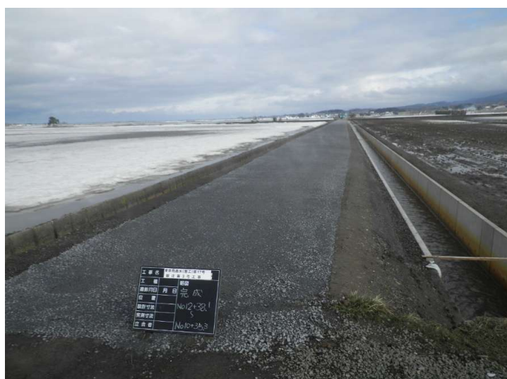
■銀ほ第3号工事_青森市浪岡 完成検査：令和7年5月8日
