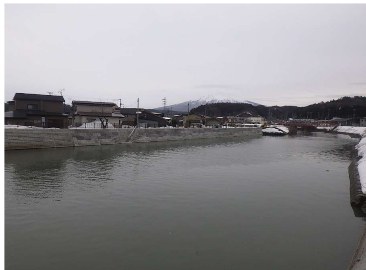
■中村川激甚災害対策特別緊急工事_鱒ヶ沢町 完成検査：令和8年3月12日
