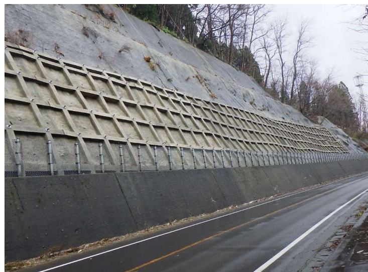
■ 国道101号道路災害防除工事_深浦町 完成検査：令和7年12月24日
