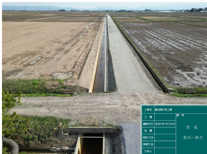
■銀ほ第2号工事_青森市浪岡 完成検査：令和7年5月20日
