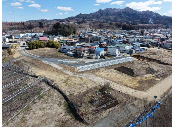
■馬淵川広域河川改修(駅前地区下流)工事_南部町 完成検査：令和8年3月24日
