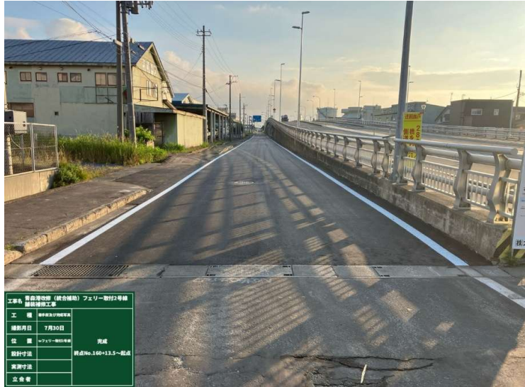
■青森港改修（統合補助）フェリー取付2号線舗装補修工事_青森市 完成検査：令和7年9月18日
