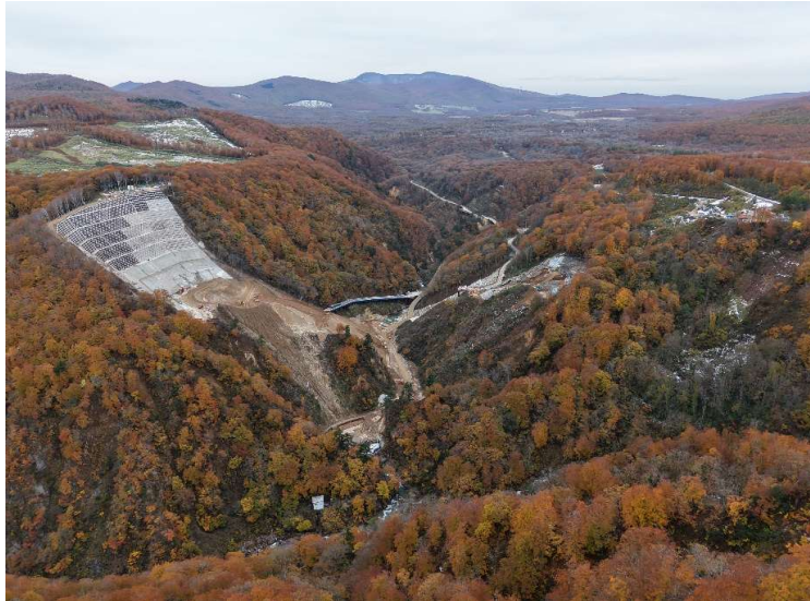
■駒込ダム本体建設工事_青森市 中間検査：令和7年12月24日
