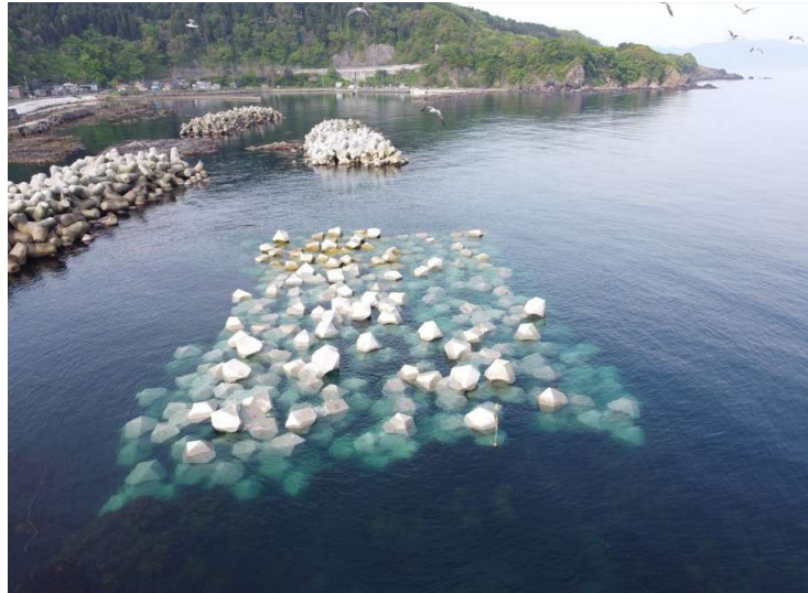
■一本木漁港海岸保全施設整備連携工事_今別町 完成検査：令和7年6月11日
