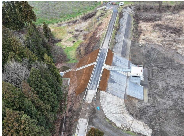
■高館新ため池第2号工事_黒石市 完成検査：令和8年2月27日
