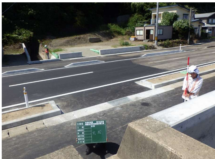
■国道280号交通安全対策工事_外ヶ浜町 完成検査：令和7年10月9日
