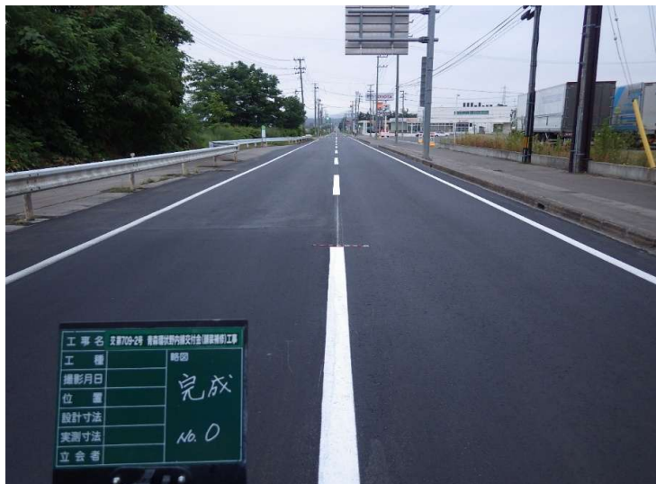
■青森環状野内線交付金（舗装補修）工事_青森市 完成検査：令和7年9月26日
