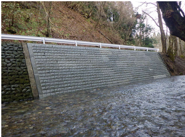
■三厩小泊線災害防除工事_外ヶ浜町 完成検査：令和7年12月25日
