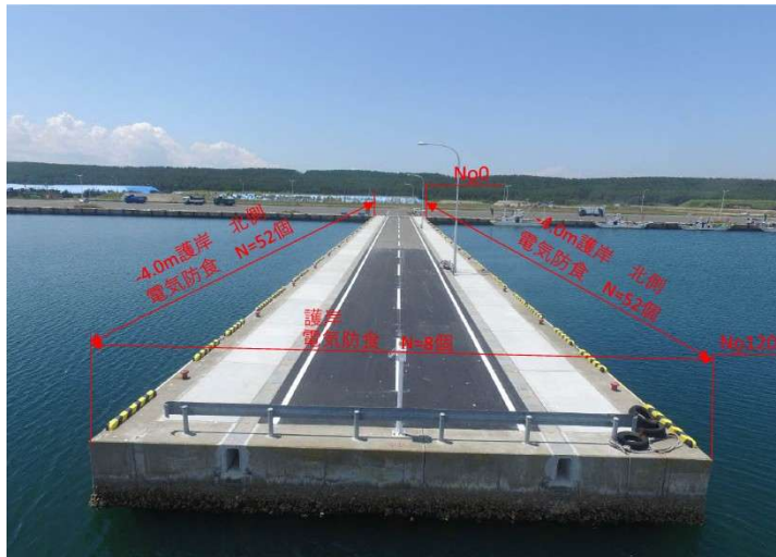
■三八地区(三沢漁港)水産物供給基盤保全工事_三沢市 完成検査：令和7年12月24日
