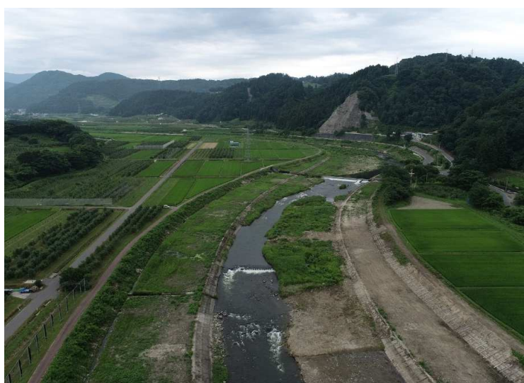
■平川外総合流域防災(浅瀬石川加速化対策)工事_黒石市 完成検査：令和6年9月5日
