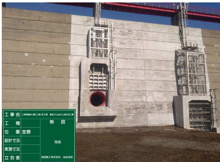
■夏坂ダム防ダム第2号工事_田子町 完成検査：令和7年3月27日
