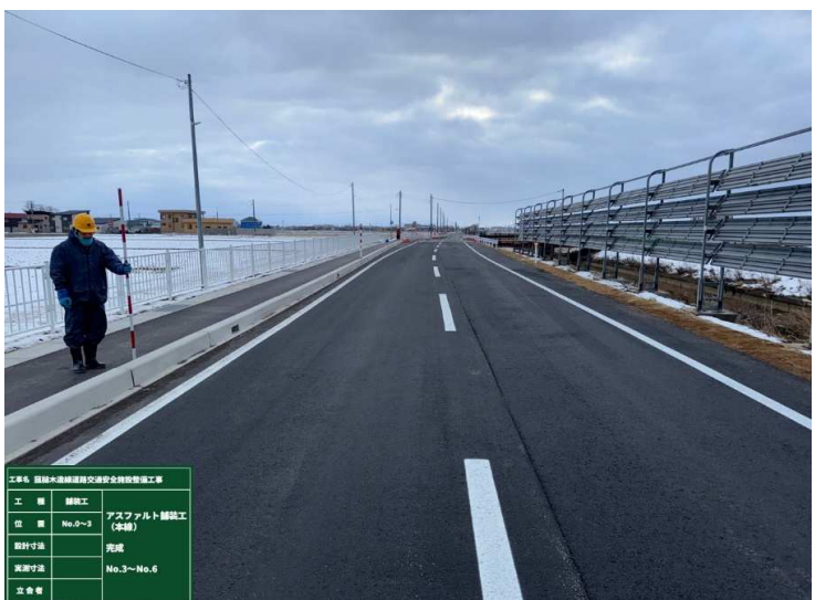
■菰槌木造線道路交通安全施設整備工事_つがる市 完成検査：令和6年12月17日
