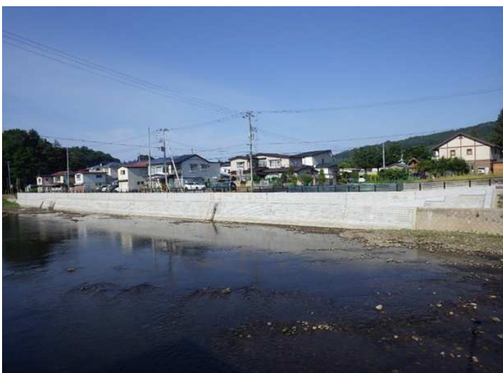
■馬淵川広域河川改修(関根川原地区)工事_三戸町 完成検査：令和6年7月12日
