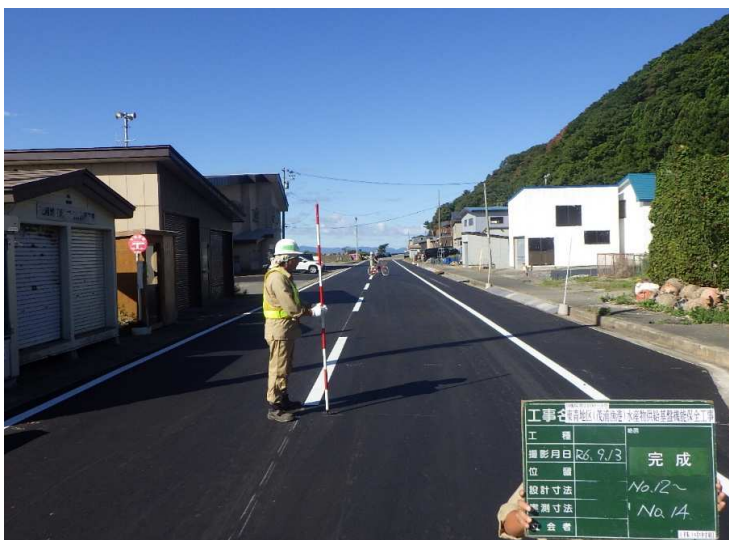
■ 東青地区(茂浦漁港)水産物供給基盤機能保全工事_平内町 完成検査：令和6年10月24日
