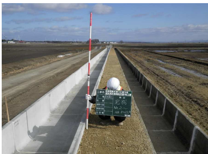
■越水用水長寿防災第1号工事_つがる市 完成検査：令和7年3月28日
