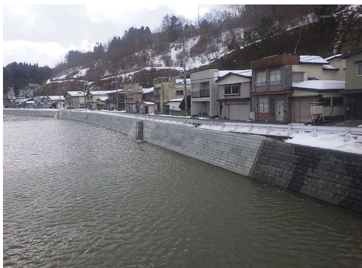
■中村川激甚災害対策特別緊急工事_鯉ヶ沢町 完成検査：令和7年3月11日
