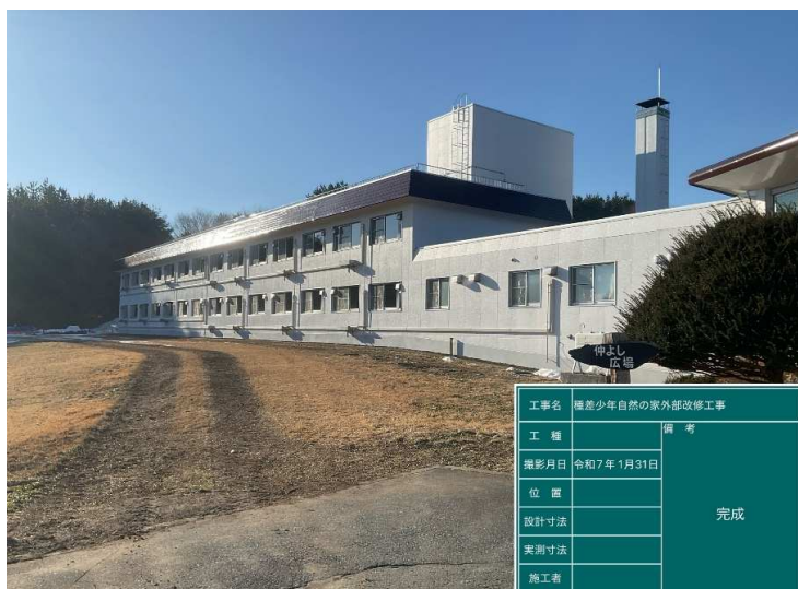
■種差少年自然の家外部改修工事_八戸市 完成検査：令和7年2月20日
