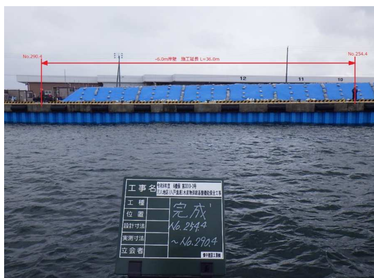
■三八地区(八戸漁港)水産物供給基盤機能保全工事_八戸市 完成検査：令和7年3月18日
