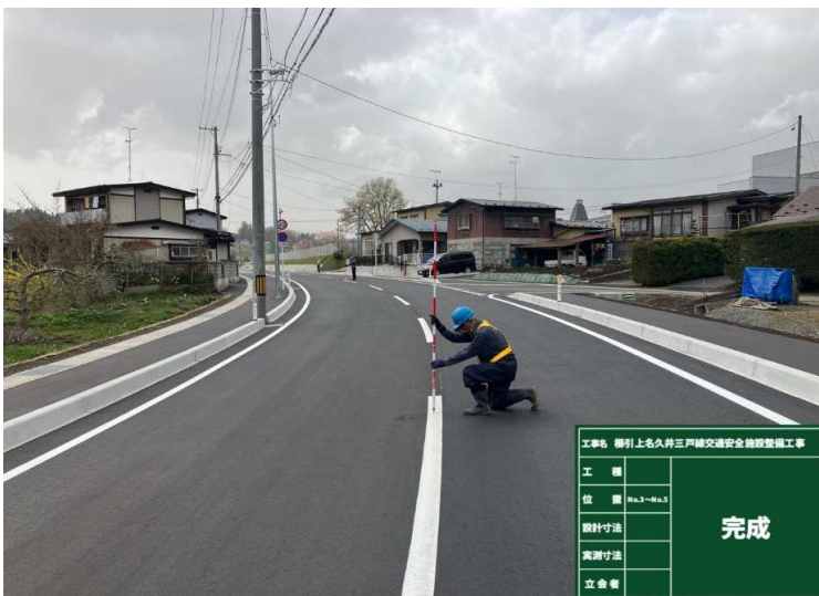
■櫛引上名久井三戸線交通安全施設整備工事_三戸町 完成検査：令和6年5月10日
