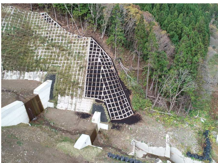
■令和6年度県営自然災害防止工事_風間浦村 完成検査：令和6年11月29日
