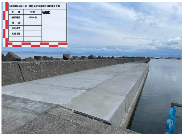
■ 蓬田地区漁港施設機能強化工事_蓬田村 完成検査：令和6年5月31日
