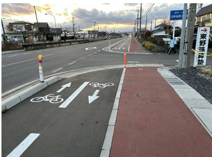
■三沢十和田線交通安全施設整備工事_十和田市 完成検査：令和6年9月9日
