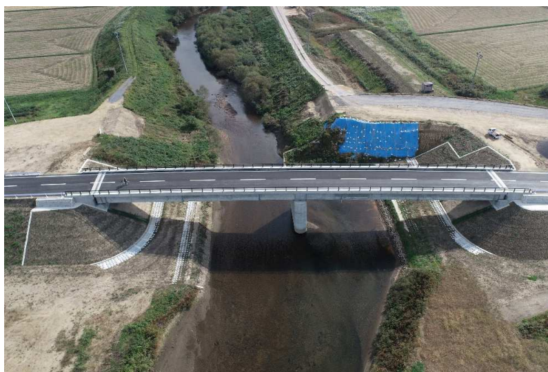
■ 金木川広域河川改修(加速化対策)工事_五所川原市 完成検査：令和6年10月18日
