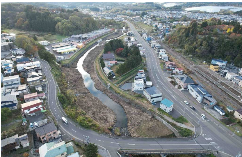
■新城川総合流域防災(加速化対策)工事_青森市 完成検査：令和7年2月28日
