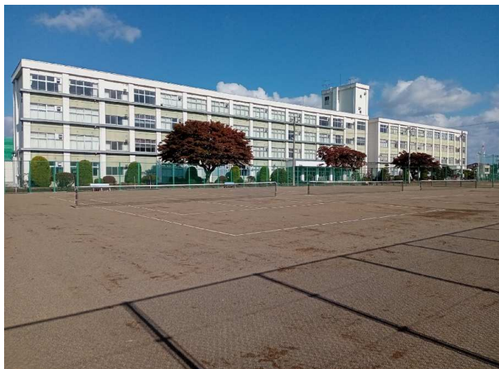
■七戸高等学校運動場改修工事_七戸町 完成検査：令和7年1月16日
