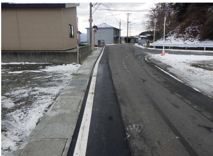
■国道339号交付金(凍雪害防止)工事_外ヶ浜町 完成検査：令和7年1月9日
