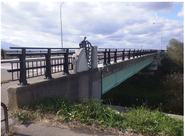
■妙堂崎五所川原線橋梁補修(五所川原大橋)工事_つがる市 完成検査：令和6年12月10日
