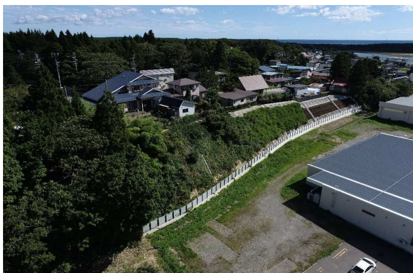
■家ノ前区域急傾斜地対策工事_六ヶ所村 完成検査：令和6年10月11日
