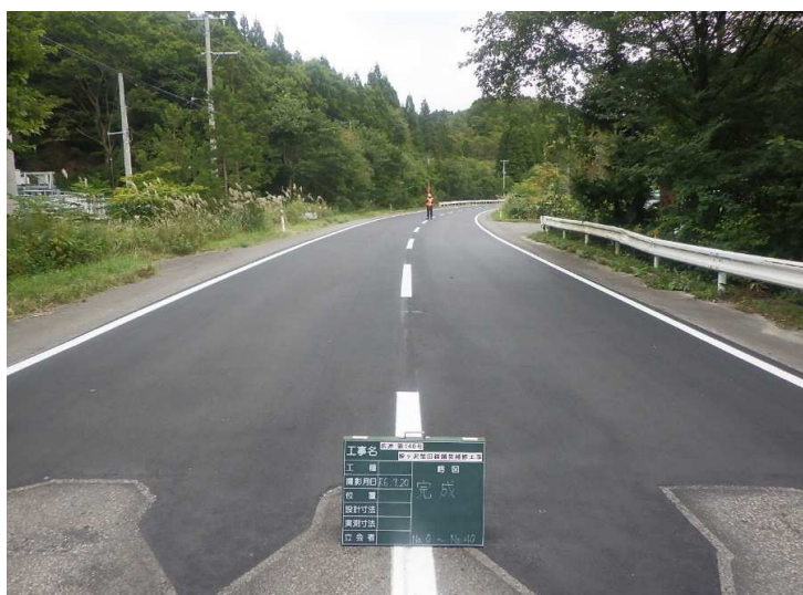
■ 鯨ヶ沢蟹田線舗装補修工事_中泊町 完成検査：令和6年10月23日
