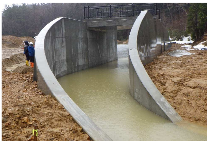
■田ノ沢ため等第3号工事_中泊町 完成検査：令和7年3月27日
