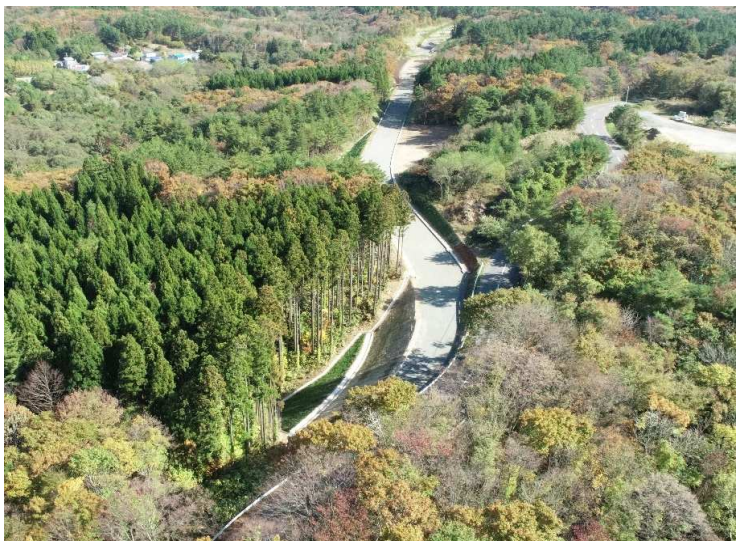
■国道339号道路改良工事_五所川原市 完成検査：令和6年11月27日
