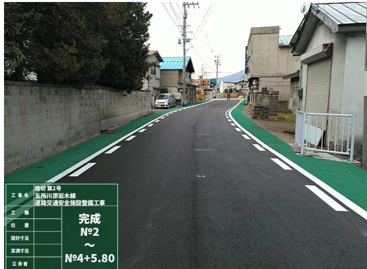
■五所川原岩木線道路交通安全施設整備工事_板柳町 完成検査：令和6年12月19日
