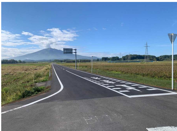
■廻堰中央農道保全第1号工事_鶴田町 完成検査：令和6年9月27日
