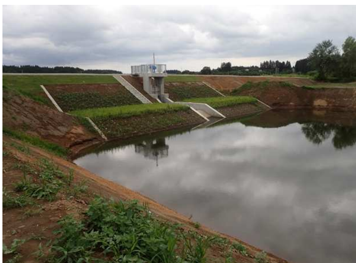
■高瀬川(七戸川)大規模特定河川改修大谷地排水樋門工事_東北町 完成検査：令和6年7月30日
