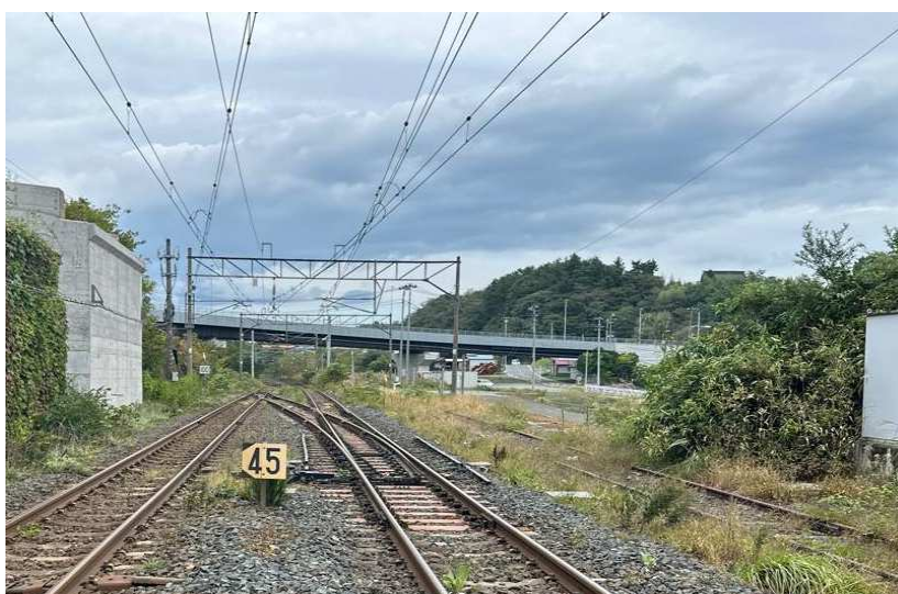
■三沢十和田線橋梁架替（古間木橋）工事_三沢市 完成検査：令和6年11月12日
