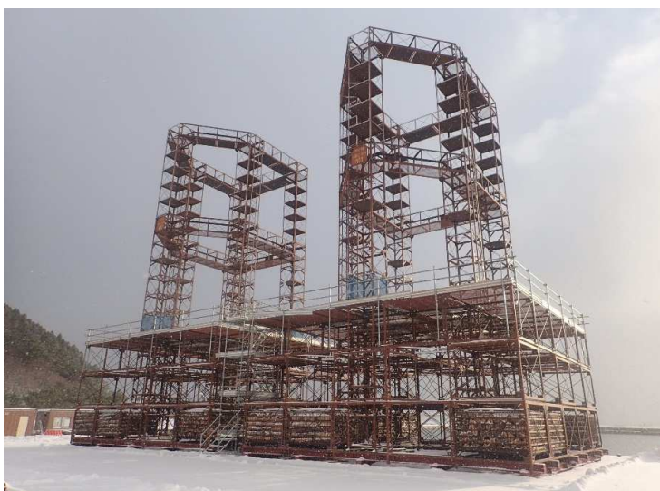
■青森県津軽海峡地区（東部漁礁第1工区）水産環境整備工事_佐井村 中間検査：令和7年1月15日
