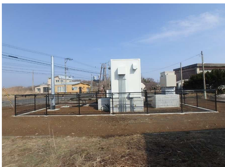
■モニタリングポスト（有戸局）新築工事_野辺地町 完成検査：令和7年3月7日
