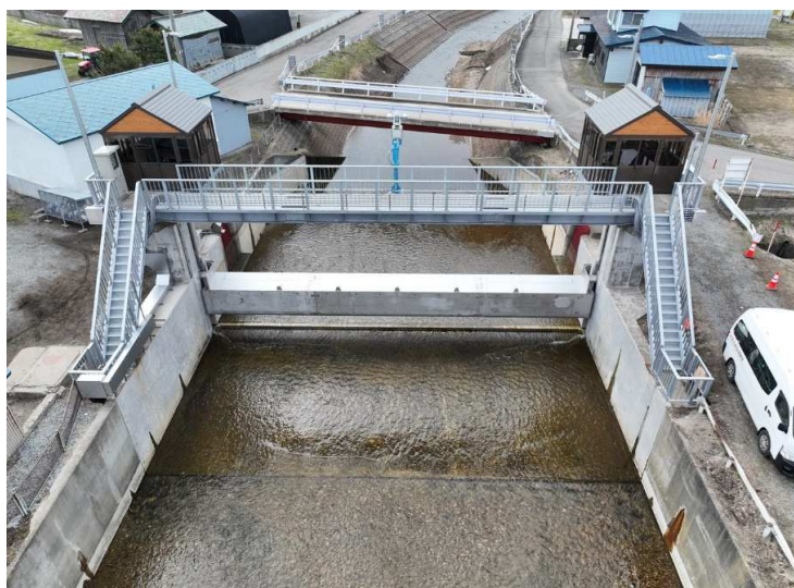
■小田川南部合理化34号工事_五所川原市 完成検査：令和6年4月25日
