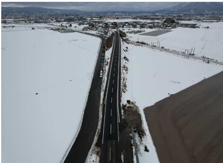
■弘前環状線舗装道維持修繕工事_田舎館村 完成検査：令和7年1月21日
