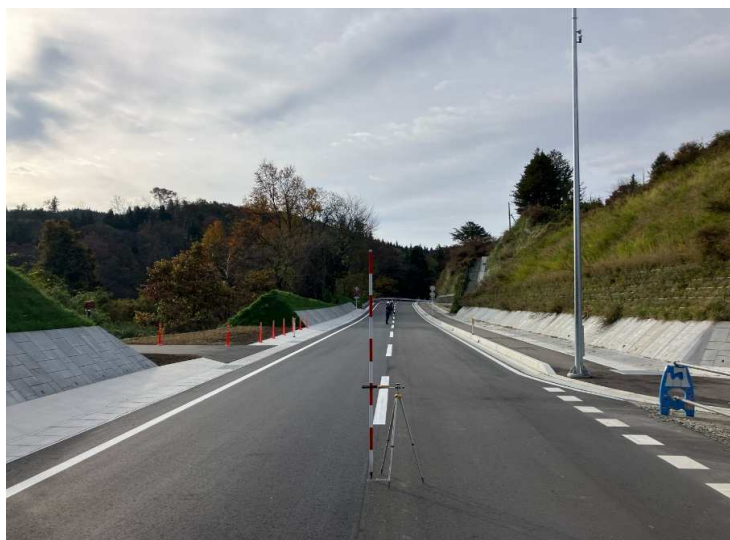
■国道454号交通安全施設整備工事_新郷村 完成検査：令和6年11月20日
