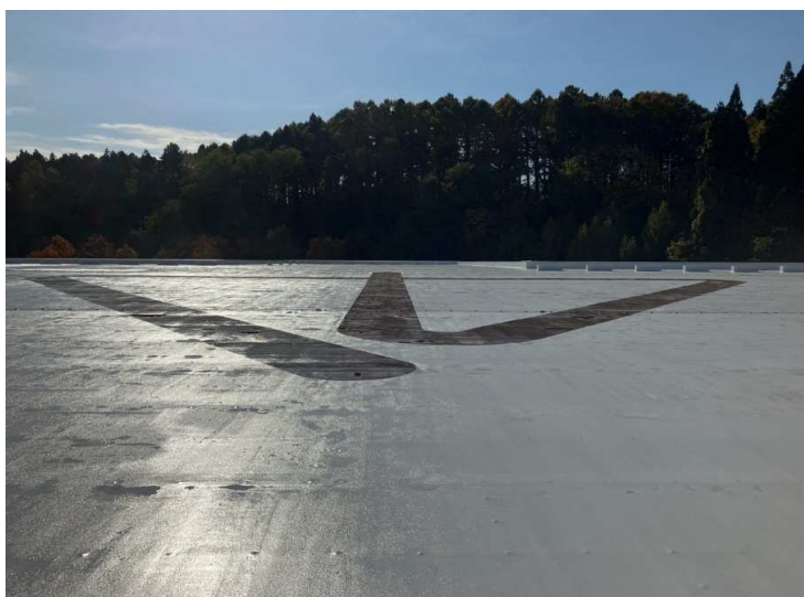
■青森県立美術館屋上防水改修工事_青森市 完成検査：令和6年11月25日
