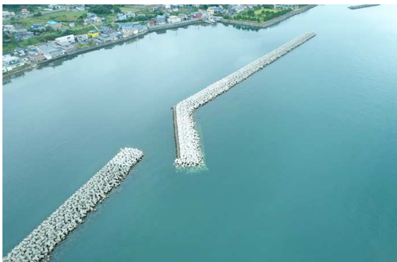
■野辺地港高潮対策（離岸堤嵩上げ）工事_野辺地町 完成検査：令和6年10月8日
