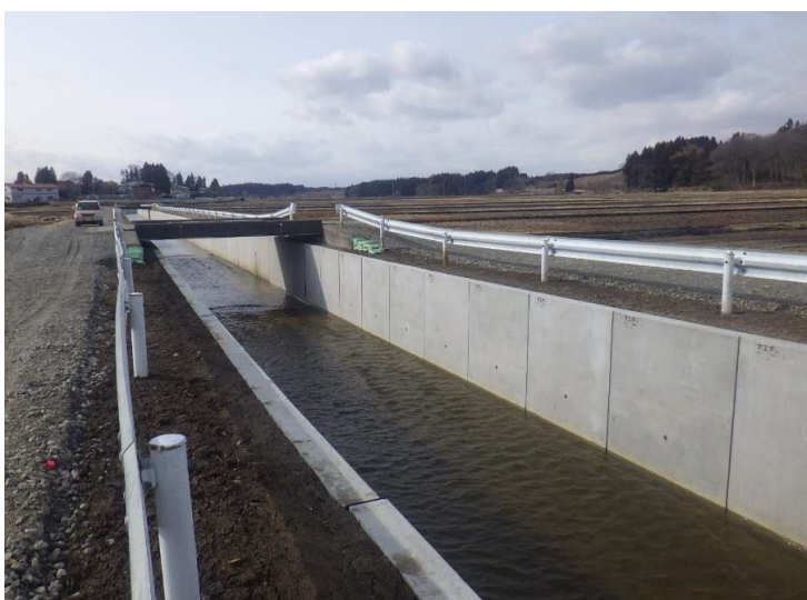
■高屋敷排水路長寿防災第6号工事_六戸町 完成検査：令和7年3月27日
