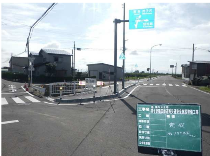
■持子沢鶴田線道路交通安全施設整備工事_鶴田町 完成検査：令和6年9月13日
