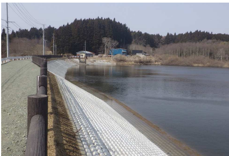
■上谷地中堤ため池第5号工事_おいらせ町 完成検査：令和7年3月25日
