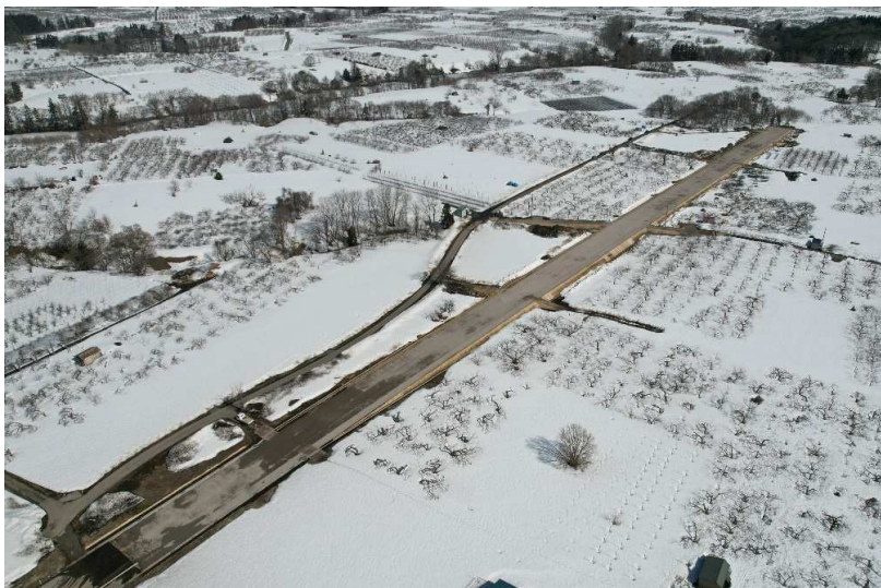
■常海橋銀線交付金(道路改築)工事_青森市浪岡 完成検査：令和7年3月28日
