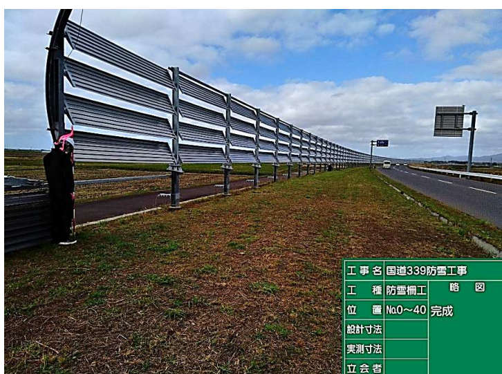
■ 国道339号防雪工事_五所川原市 完成検査：令和6年11月27日
