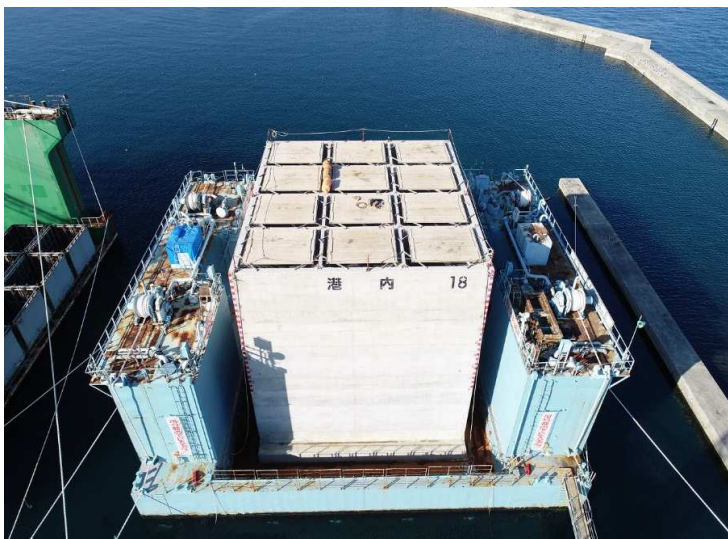
■佐井地区水産生産基盤整備工事_佐井村 指定部分完了検査：令和6年12月16日
