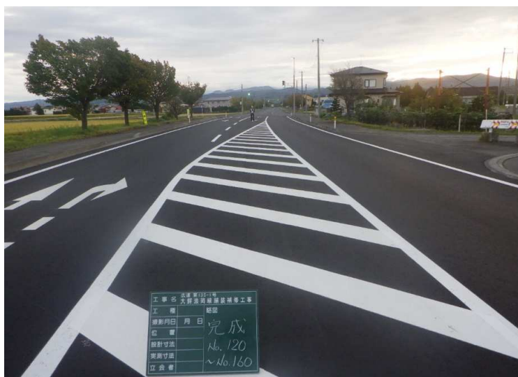
■大鰐浪岡線舗装補修工事_平川市 完成検査：令和6年10月11日
