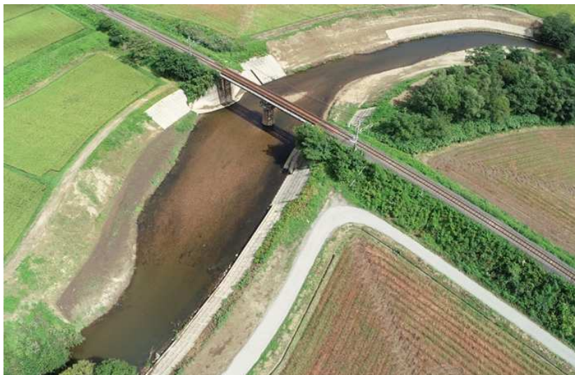
■蟹田川総合流域防災(加速化対策)工事_外ヶ浜町 完成検査：令和6年9月18日
