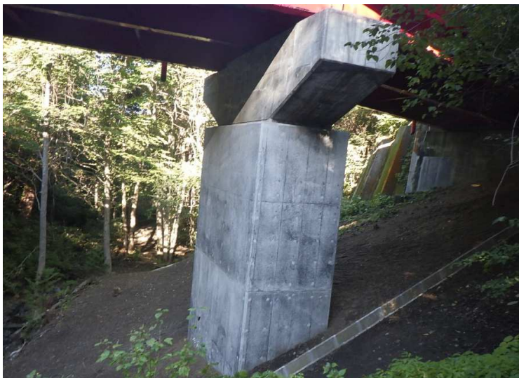
■三厩停車場龍飛崎線橋梁補修(第3鳴神沢橋)工事_外ヶ浜町 完成検査：令和6年10月10日
