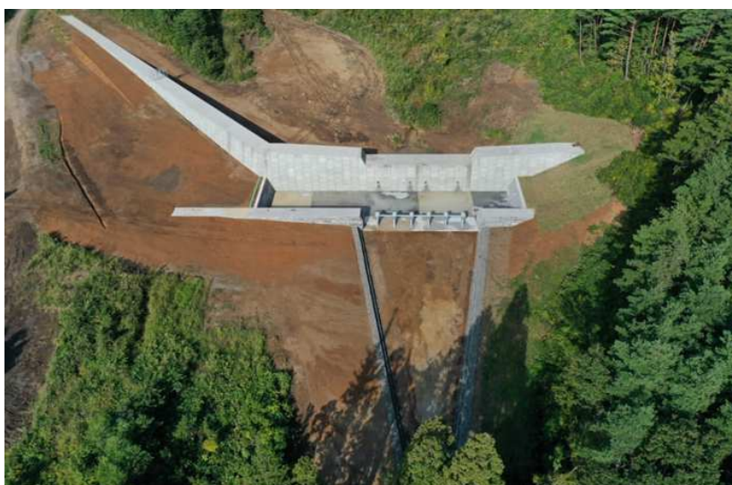
■大荒川火山砂防工事_むつ市 完成検査：令和6年10月18日
