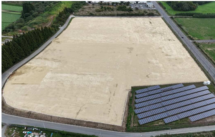
■金矢工業団地5－1環境整備工事_六戸町 完成検査：令和6年10月24日
