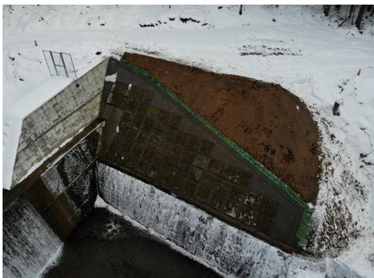
■和田川第3号砂防堰堤修繕工事_七戸町 完成検査：令和6年12月26日
