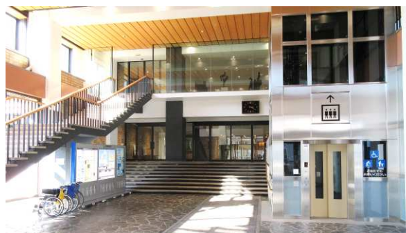
正面玄関（改修後）
