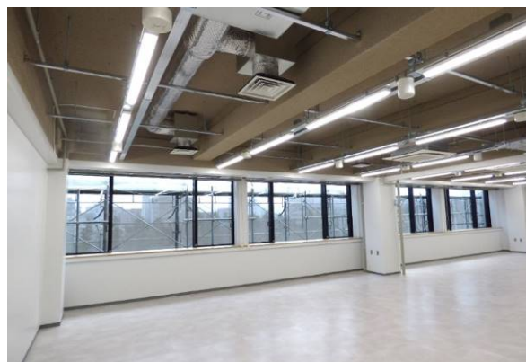
執務室（改修後）
