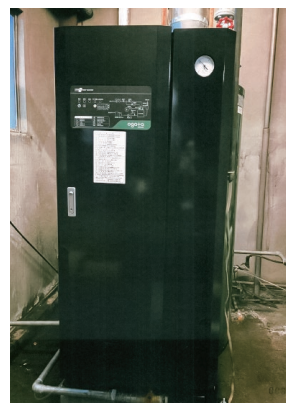
ボイラー設置施工
