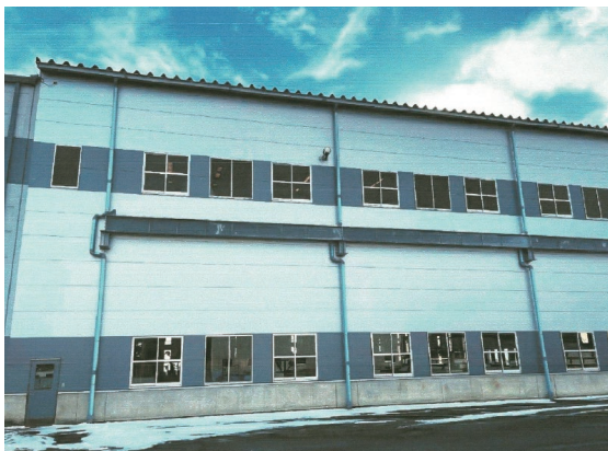
工場外壁の水銀灯
