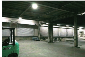
■屋外荷捌き所
