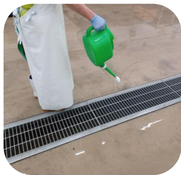
15 側溝を次亜塩素で消毒する。
