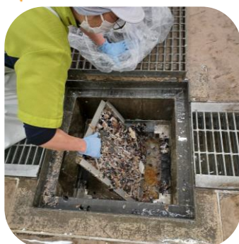
12 側溝のゴミを除去する。
