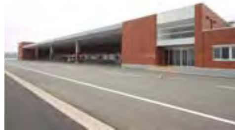
八戸漁港館鼻地区のHACCP（ハザップ）対応型荷さばき施設A棟（八戸市提供）
