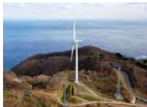
竜飛風力発電所（1号機） （株）津軽半島エコエネ（外ヶ浜町の第三セクター）
