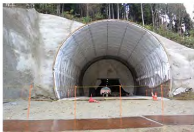
津軽蓬田トンネルから 北海道側を望む
