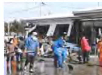
がれき・ゴミの撤去作業 (デーリー東北新聞社提供)
