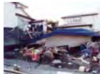
倒壊した住宅
