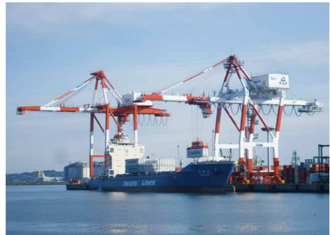
東日本大震災からの復旧を終え、復興に向けて動き出した八戸港
