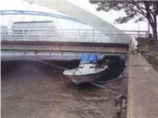
河川(堤川)への係留状況
