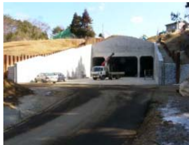
2号トンネル坑口部
