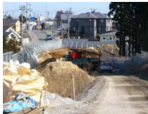
終点部(既設市道との接続部)
