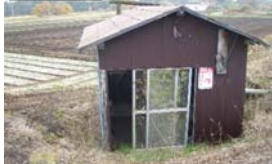
旧豊平揚水機場
