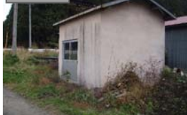
旧今熊揚水機場
