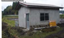
旧富庫美揚水機場
