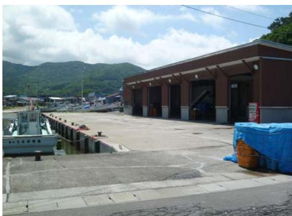
事業完了後は、陸揚げ岸壁が前出しされ、荷捌き所前面の作業スペースが広がったことから、作業効率が向上した。
