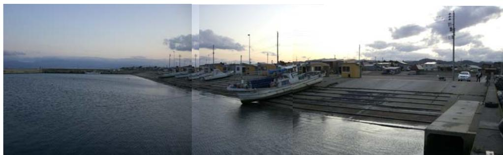
事業完了後は、適正な勾配を有し、前面の水深が確保された船揚場が整備され、上下架用の附属設備(滑り材)も設置されたことにより、漁船の上下架作業の手間が非常にスムーズとなった。
