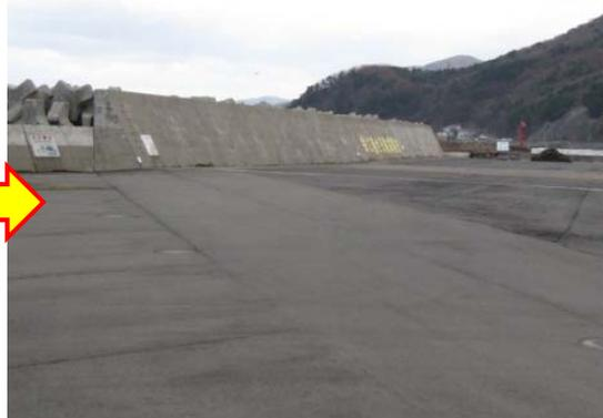
事業実施前は、低気圧などの荒天時に護岸から越波した波浪で野積場が冠水し、漁具の流失や飛散などの被害があったが、事業完了後は、護岸の嵩上げ整備により越波が低減され、被害が減少した。
