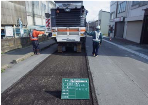
舗装工：路面切削状況
