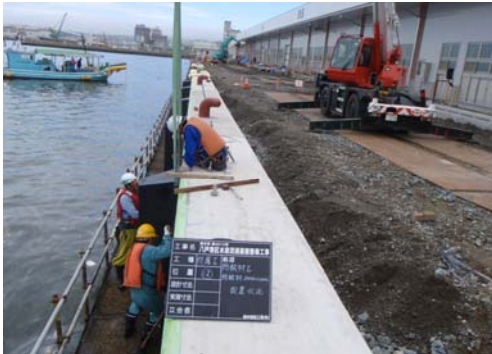
付属工：防舷材取付状況
