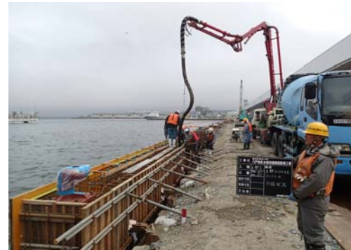
上部工：コンクリート打設状況
