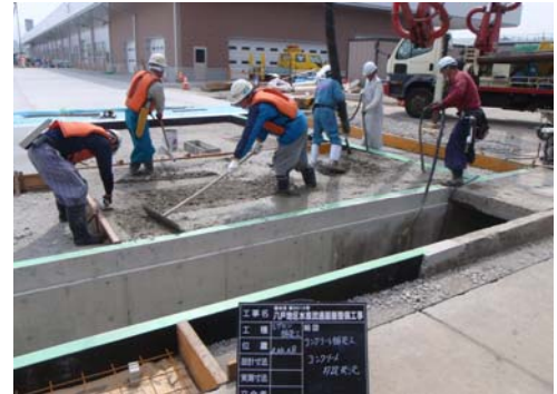
コンクリート舗装工：コンクリート打設状況
