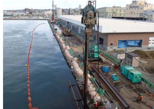
本體工：鋼矢板打設状況
