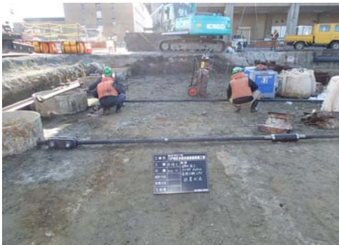
本體工：タイロッド取付状況
