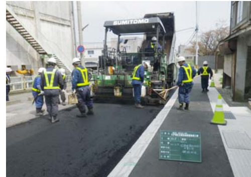
舗装工：舗設状況
