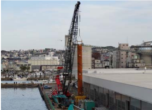
本體工：控鋼管杭打設状況
