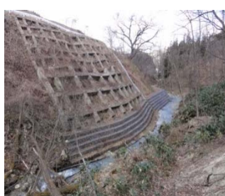
5-17'ロック法枠工・アンカー工
