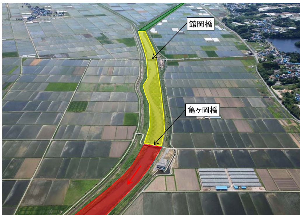
②現況写真(未改修区間)
