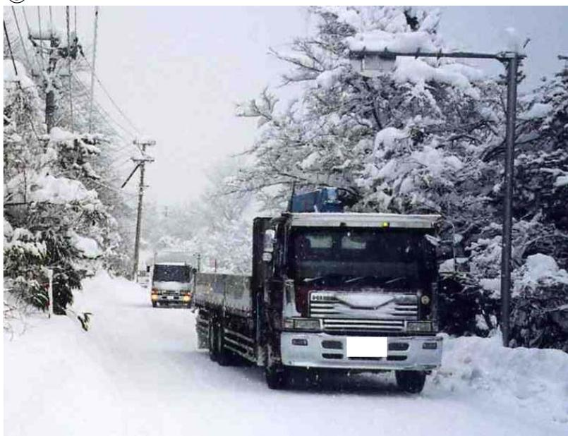
路肩が狭いため(堆雪幅がないため)、冬期間においては2車線の走行幅員が確保されず、車両同士のすれ違いが困難な状況となっている。
