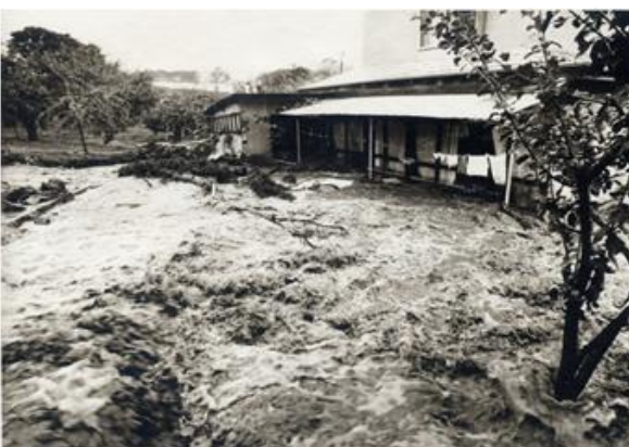
③浸水被害状況(昭和50年6月)
