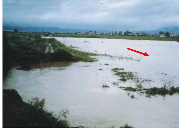
④浸水被害状況(平成2年9月)
