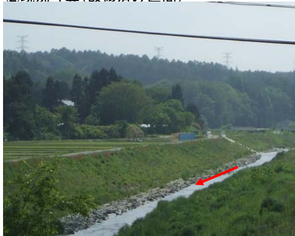
②現況写真(改修済み区間)
